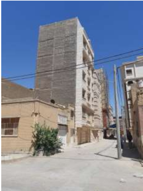
تصویر ۱-۲ نمونه‌ای از بروز نشست غیریکنواخت در ساختمان یسنا، شهر آبادان
